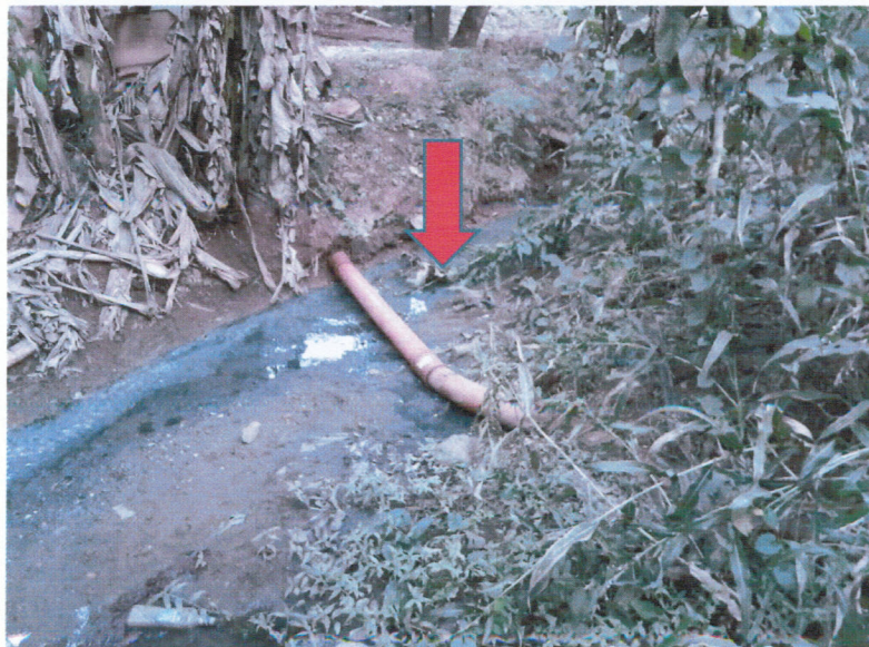
Foto do reparo da rede
