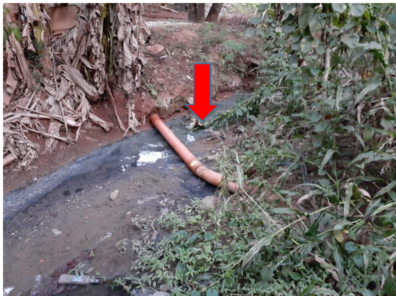
Foto do reparo da rede
