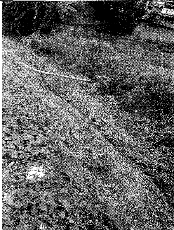
4.3 – Ponto 1: Destaque para encanamento da BRK Ambiental referente ao sistema de coleta de esgoto.
