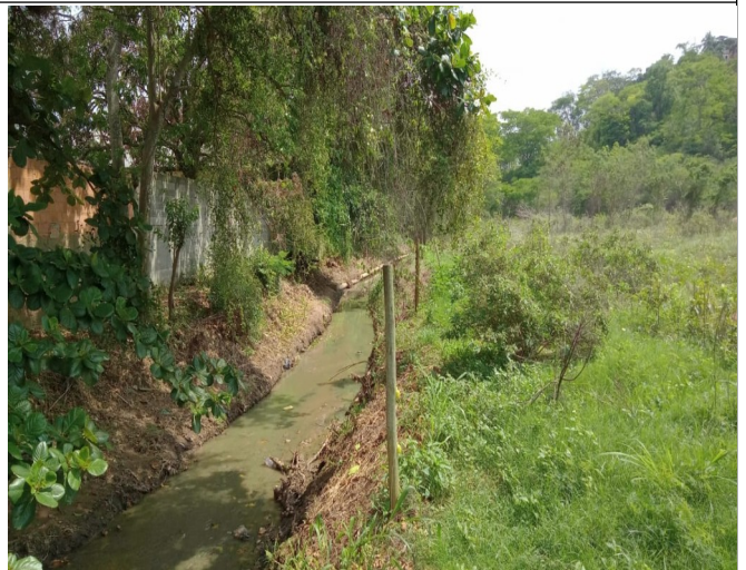
Figura 21. Trecho/Ponto 05: Água de coloração esverdeada e com odor de esgoto sanitário, bem como alguns resíduos sólidos diversos perfazendo o leito. Sugere-se limpeza manual somente.
