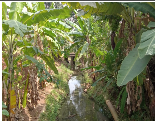
Figura 11. Trecho/Ponto 03: Água de coloração esverdeada e com odor de esgoto sanitário, bem como alguns resíduos sólidos diversos perfazendo o leito. Sugere-se limpeza manual somente.
