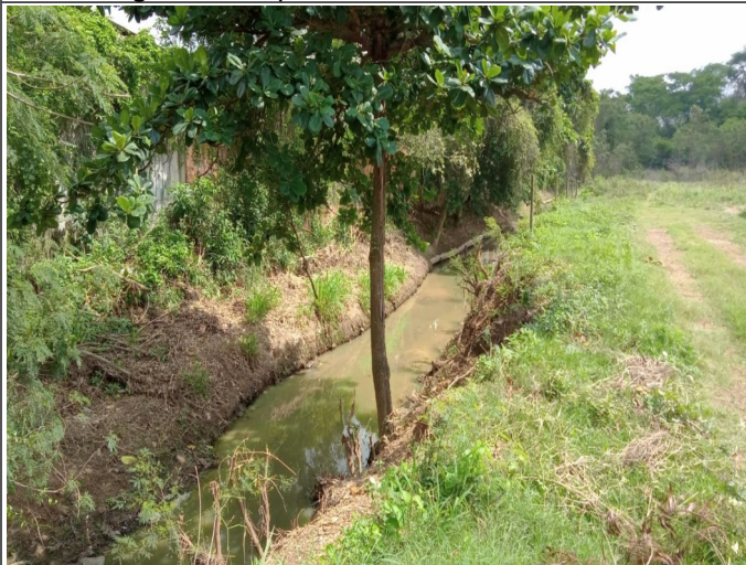
Figura 20. Trecho/Ponto 05: Água de coloração esverdeada e com odor de esgoto sanitário, bem como alguns resíduos sólidos diversos perfazendo o leito. Sugere-se limpeza manual somente.
