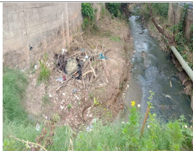
Figura 41. Trecho/Ponto 10: Água de coloração esverdeada e com odor de esgoto sanitário, bem como alguns resíduos sólidos diversos perfazendo o leito. Sugere-se limpeza manual somente.
