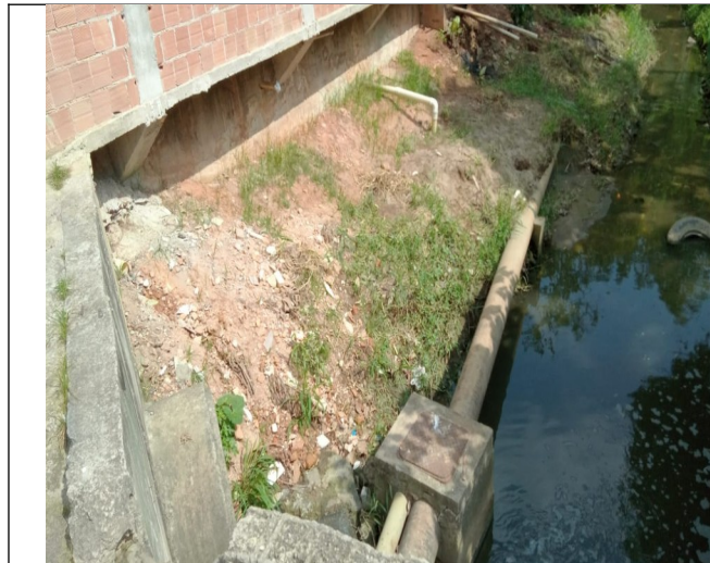
Figura 14. Trecho/Ponto 04: Água de coloração esverdeada e com odor de esgoto sanitário, bem como alguns resíduos sólidos diversos perfazendo o leito. Sugere-se limpeza manual somente.
