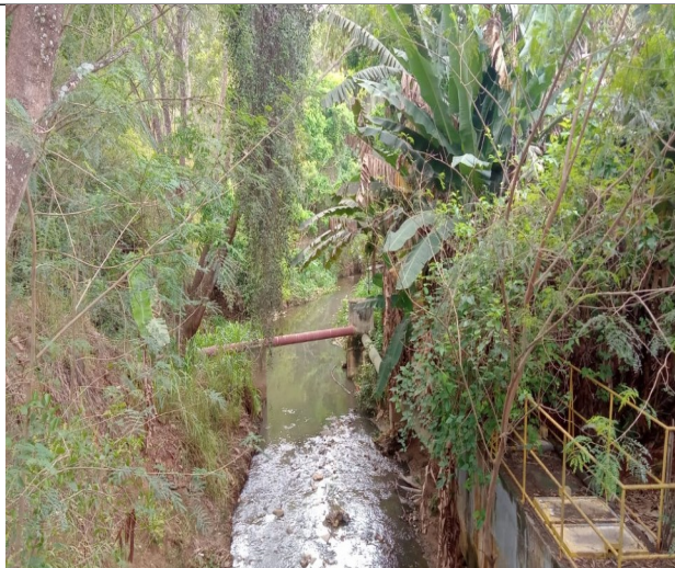
Figura 50. Trecho/Ponto 13: Água de coloração esverdeada e com odor de esgoto sanitário, bem como alguns resíduos sólidos diversos perfazendo o leito. Sugere-se limpeza manual somente.
