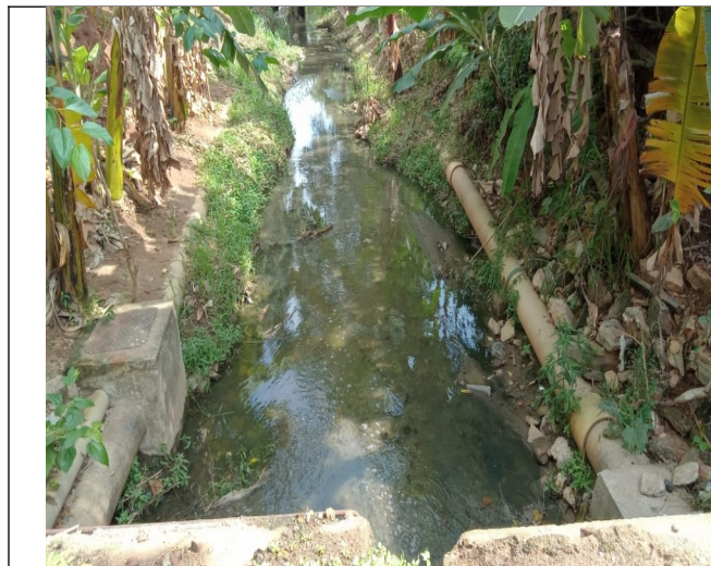
Figura 10. Trecho/Ponto 03: Água de coloração esverdeada e com odor de esgoto sanitário, bem como alguns resíduos sólidos diversos perfazendo o leito. Sugere-se limpeza manual somente.
