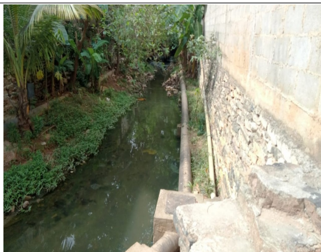
Figura 9. Trecho/Ponto 02: Água de coloração acinzentada e com odor de esgoto sanitário, bem como alguns resíduos sólidos diversos perfazendo o leito. Sugere-se limpeza manual somente.
