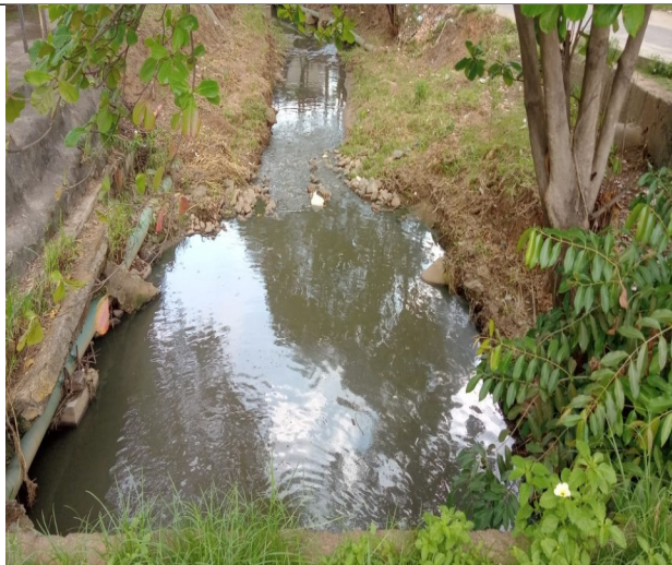
Figura 34. Trecho/Ponto 09: Água de coloração esverdeada e com muito odor de esgoto sanitário, bem como alguns resíduos sólidos diversos perfazendo o leito. Sugere-se limpeza mecanizada e manual.
