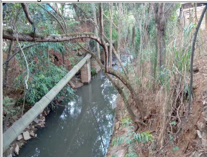
Figura 48. Trecho/Ponto 12: Água de coloração esverdeada e com odor de esgoto sanitário, bem como alguns resíduos sólidos diversos perfazendo o leito. Sugere-se limpeza manual somente.
