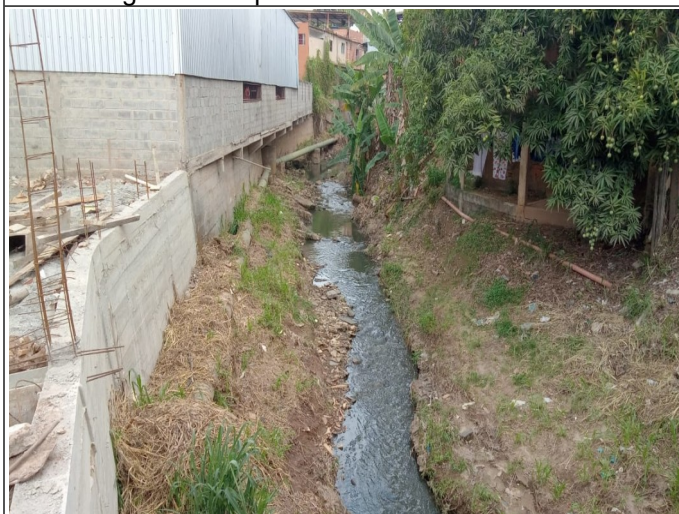
Figura 44. Trecho/Ponto 11: Água de coloração esverdeada e com odor de esgoto sanitário, bem como alguns resíduos sólidos diversos perfazendo o leito. Sugere-se limpeza manual somente.
