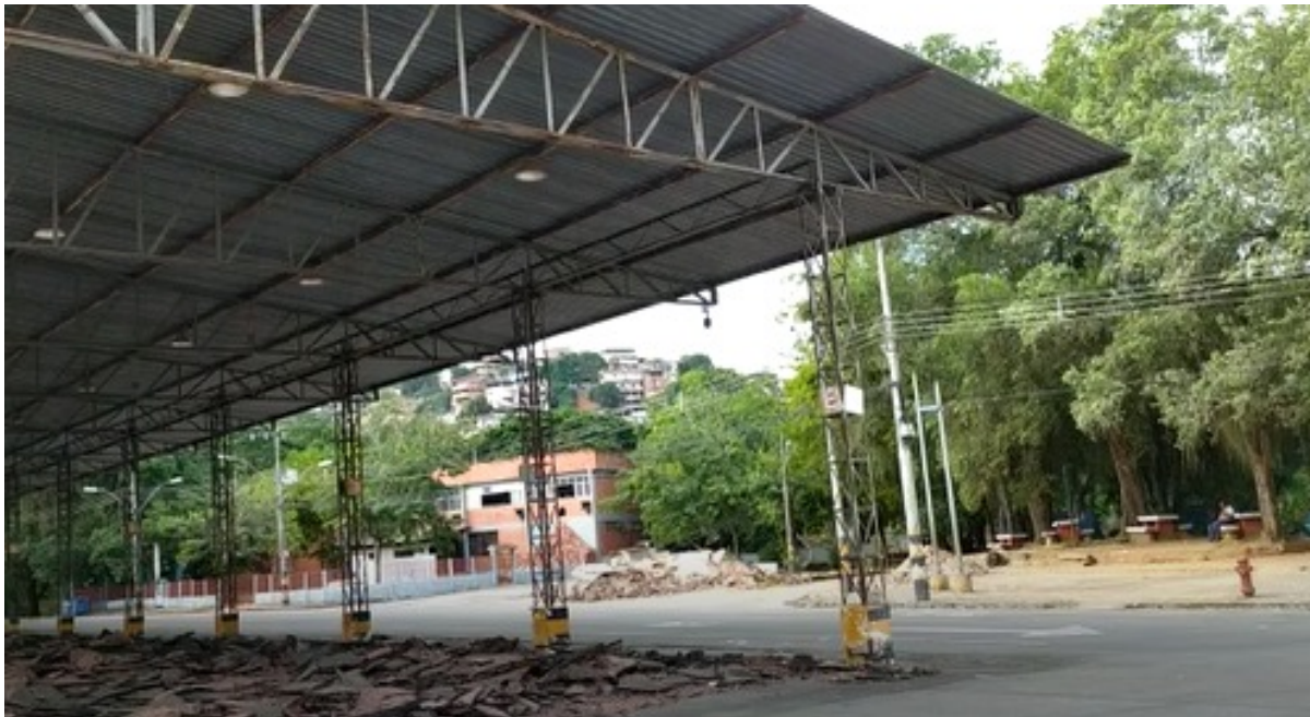
Foto 01 – Pavilhão inteiro e demolição de pavimento asfáltico.
