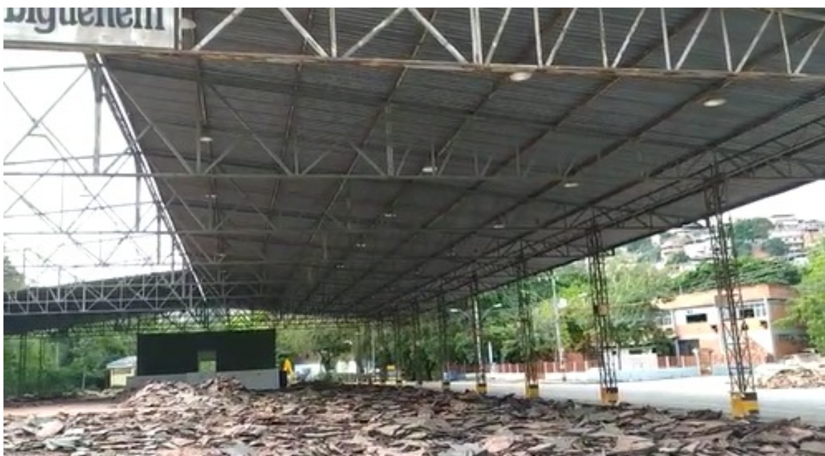
Foto 04 – Remoção de cobertura de telha metálica e de pavimento asfáltico.
