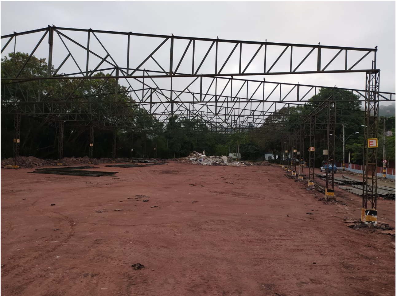
Foto 12 – Demolição de pavimento asfáltico, telhas acondicionadas e ordenadas.
