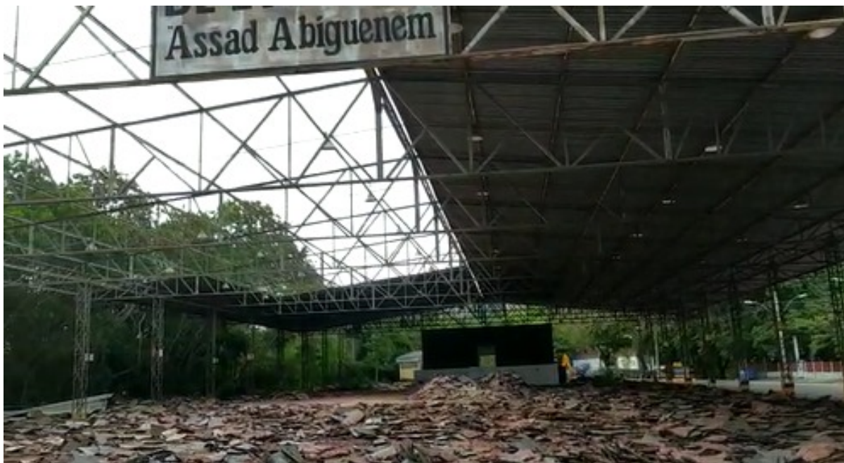
Foto 02 – Remoção de cobertura de telha metálica.
