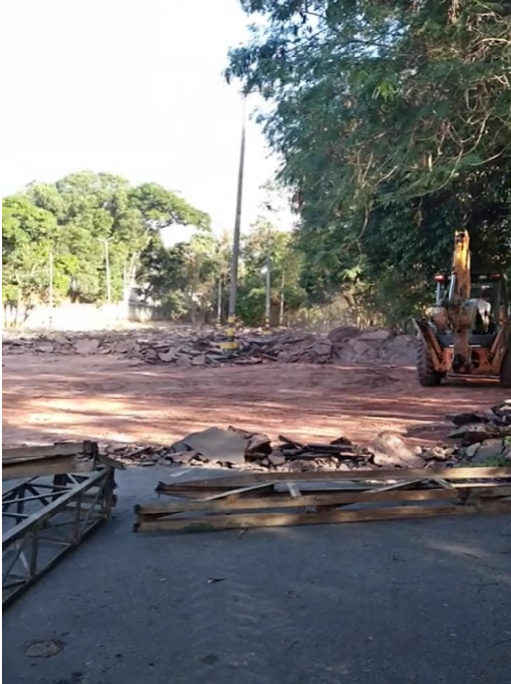
Foto 06 – Remoção de cobertura de telha metálica e de pavimento asfáltico e algumas estruturas metálicas já desmontadas.
