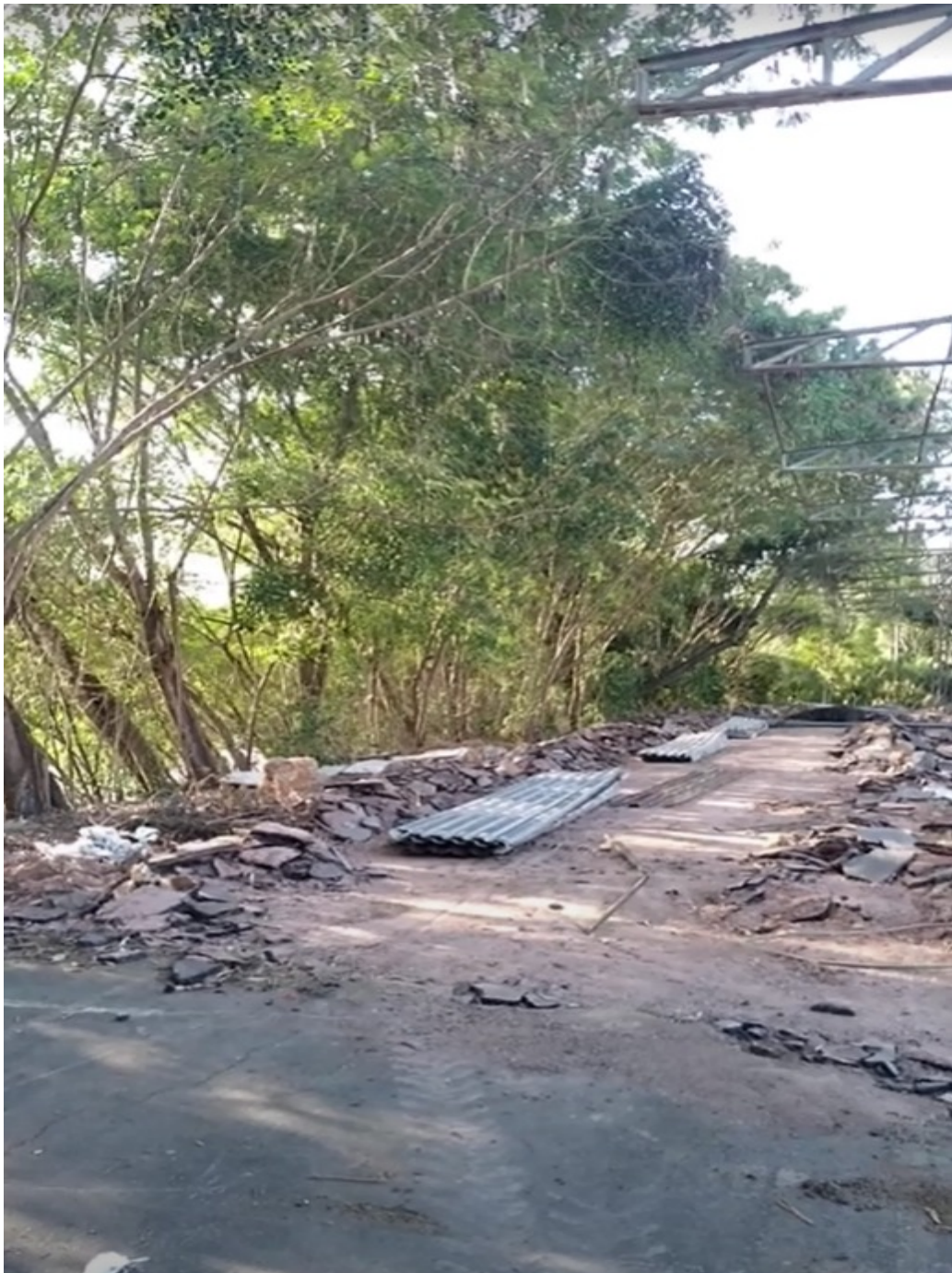
Foto 09 – Remoção de pavimento asfáltico e telhas acondicionadas e ordenadas in loco .
