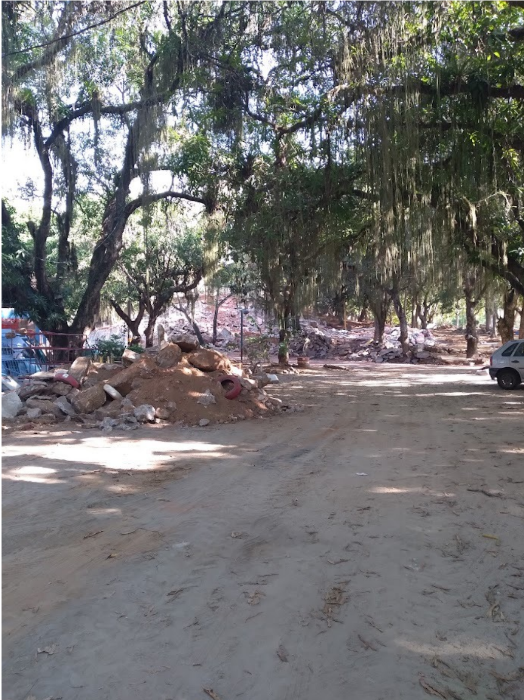
Foto 08 – Remoção de pavimento (bosque).
