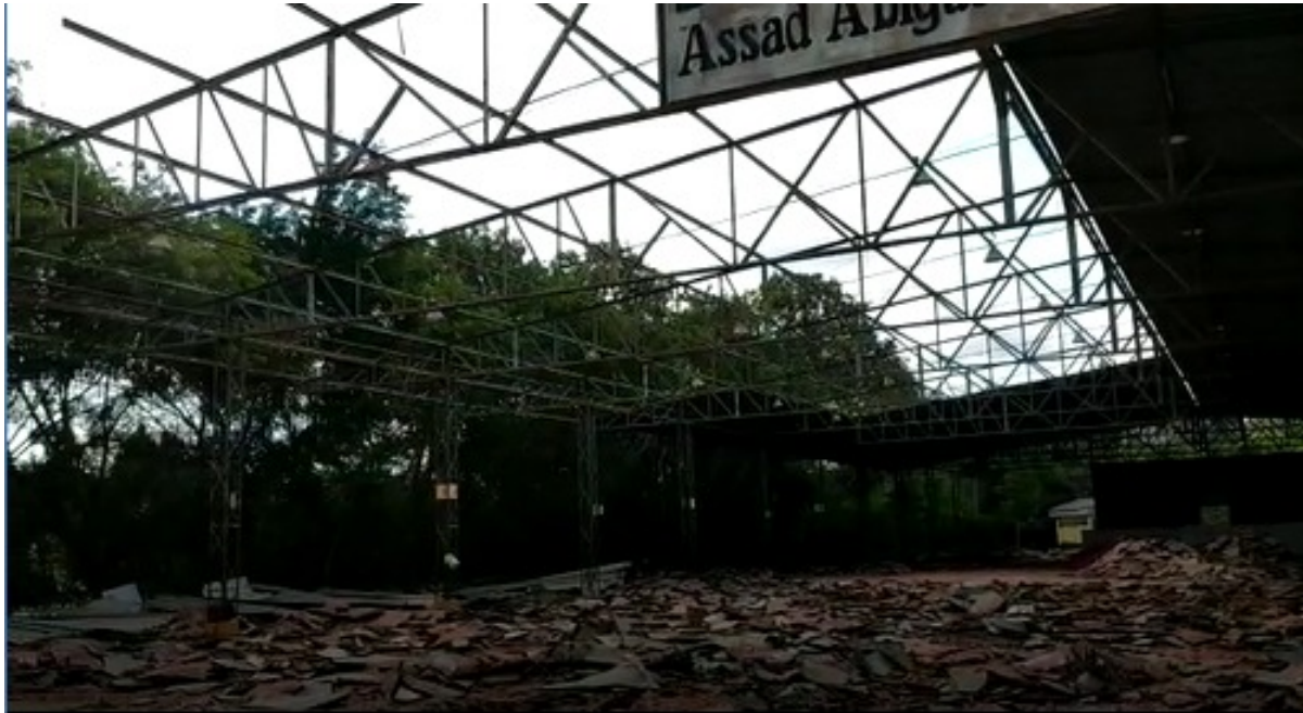
Foto 03 – Remoção de cobertura de telha metálica.
