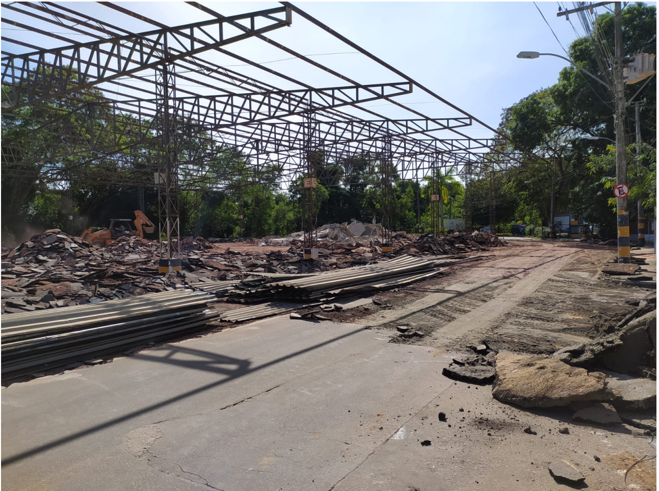
Foto 10 – Demolição de pavimento asfáltico e acondicionamento e ordenamento de telhas retiradas.
