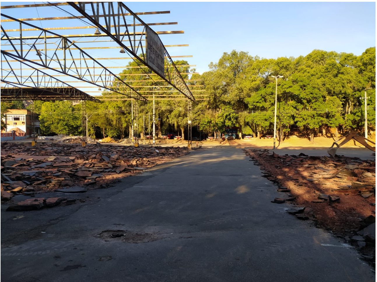
Foto 05 – Remoção de cobertura de telha metálica e de pavimento asfáltico.
