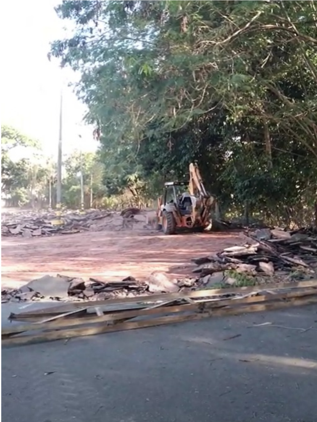
Foto 07– Remoção de pavimento asfáltico e algumas estruturas metálicas já desmontadas.
