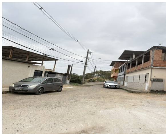
Imagem 02: Trecho da rua Cleber França sem pavimentação asfáltica.
