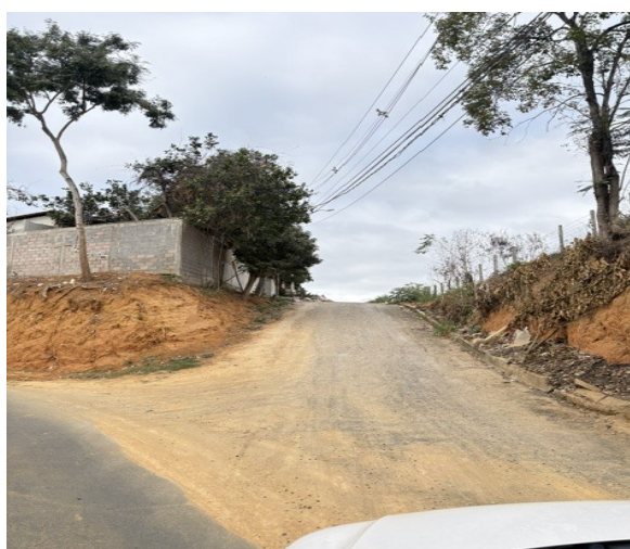
Imagem 04: Trecho da rua Cleber França sem pavimentação asfáltica.
