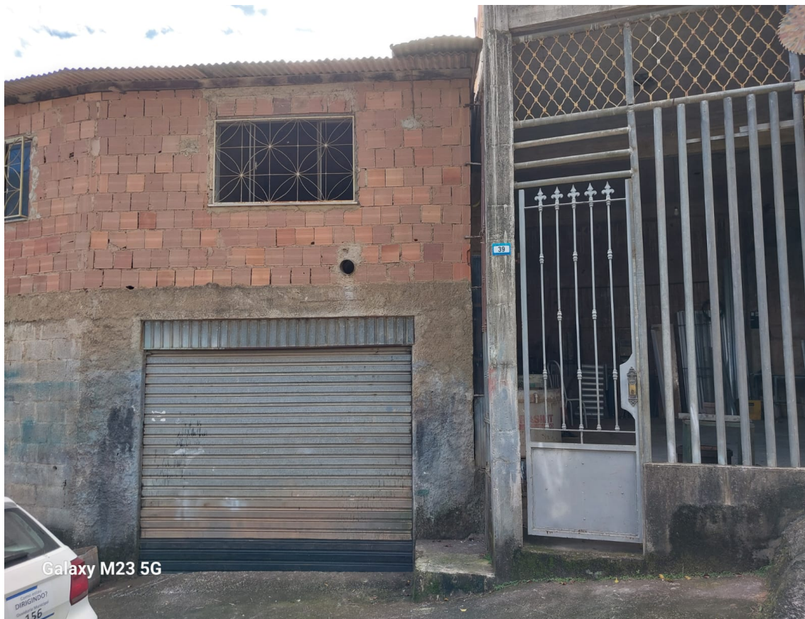
FOTO 03 – INÍCIO DO TRECHO ABERTO NA RUA JORGE SEVERINO BARBOSA (APARTIR DA CASA Nº 39)
