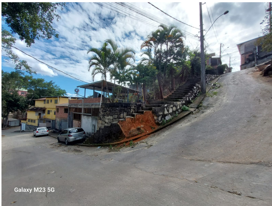
FOTO 04 – CONEXÃO DA RUA ABEL CARDOSO COELHO COM O RESTANTE DO BAIRRO A PARTIR DA RUA JORGE SEVERINO BARBOSA
