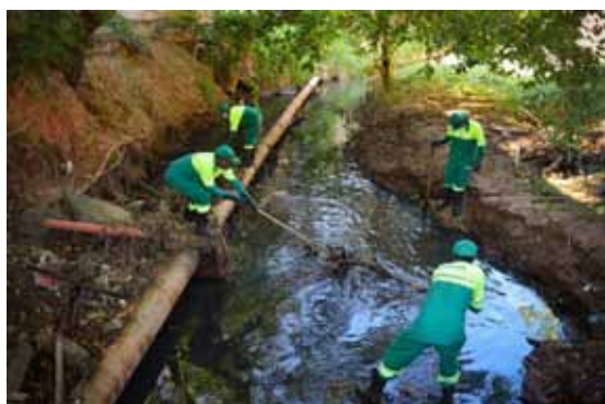
Figura 16 – Limpeza do Córrego Monte Cristo
