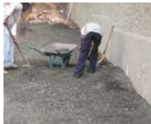
Instalação das contenções laterais, nivelamentos e compactação da base.
