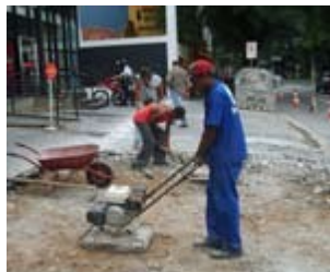
Nivelamento e compactação do subleito (terreno)
