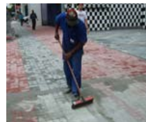
Limpeza e liberação ao tráfego
