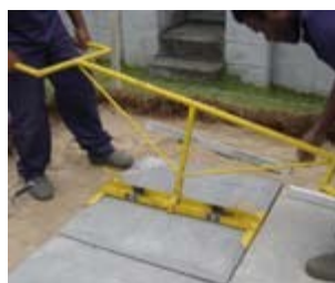
Colocação das peças de concreto com saca-placas
