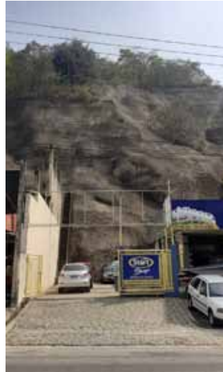
Figura 22 – Revestimento de talude, Bairro Parque Laranjeiras
