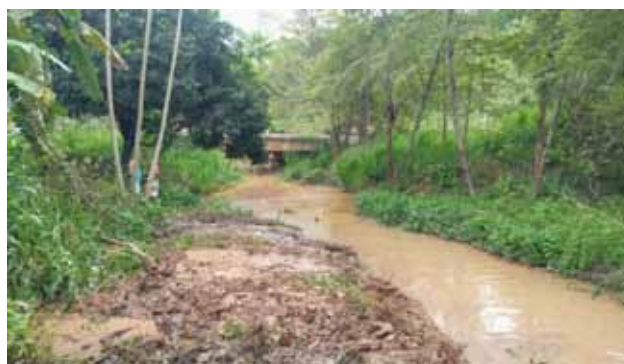
Figura 17 – Limpeza e desassoreamento de córrego em Santa Fé
