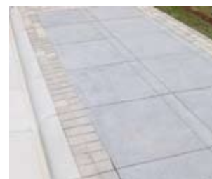
Limpeza e liberação ao tráfego
