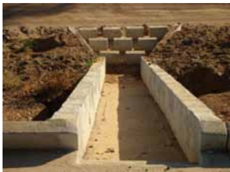
Figura 24 – Dissipador de energia em canaleta
