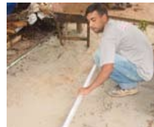
Espalhamento e nivelamento (sarrafeamento) da areia de assentamento (pó de brita)
