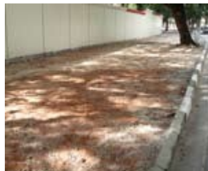
Nivelamento e compactação do subleito (terreno)
