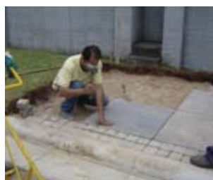
Execução de corte, ajustes e alinhamento
