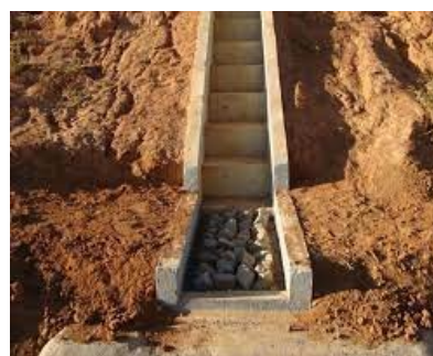
Figura 25 – Dissipadores de energia em escada hidráulica
