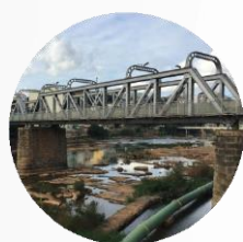
PONTE DE FERRO
