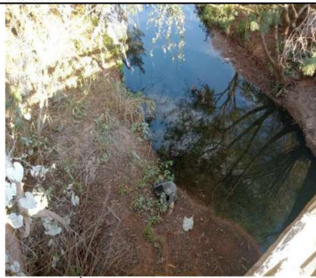
Figura 37. À jusante, detalhes da figura 36, sob a ponte.
