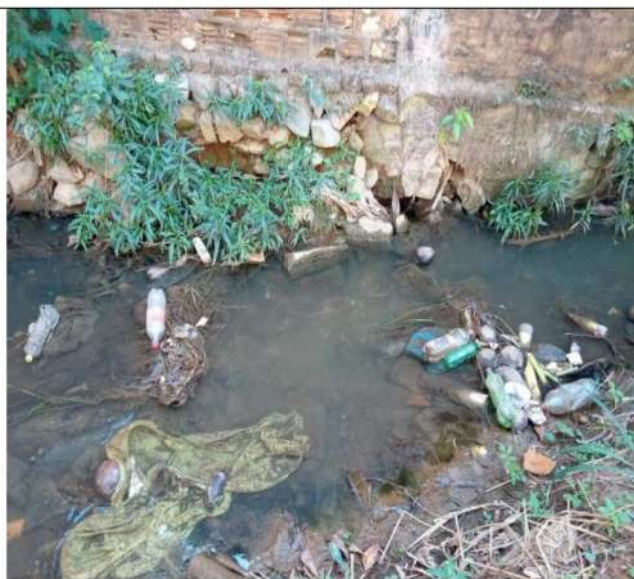
Figura 15. Perpendicular ao curso de água acinzentada: resíduos sólidos diversos dentro do leito, bem como detritos de construção.
