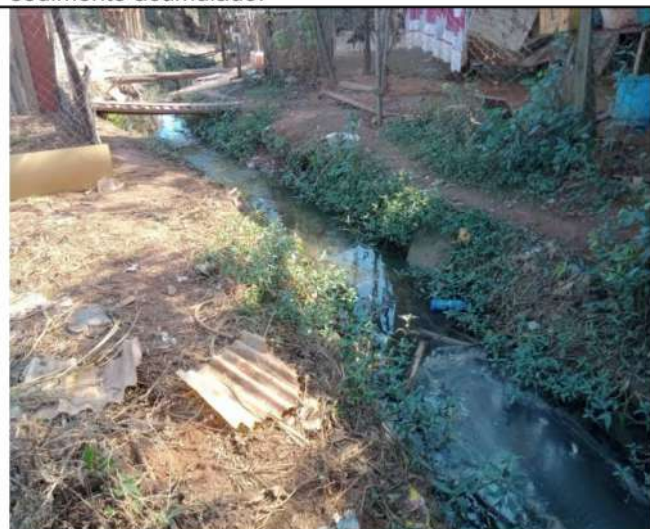
Figura 12. À jusante, água acinzentada com fluxo lento, diversos materiais sólidos dentro e sobre o leito e presença de plantas aquáticas.
