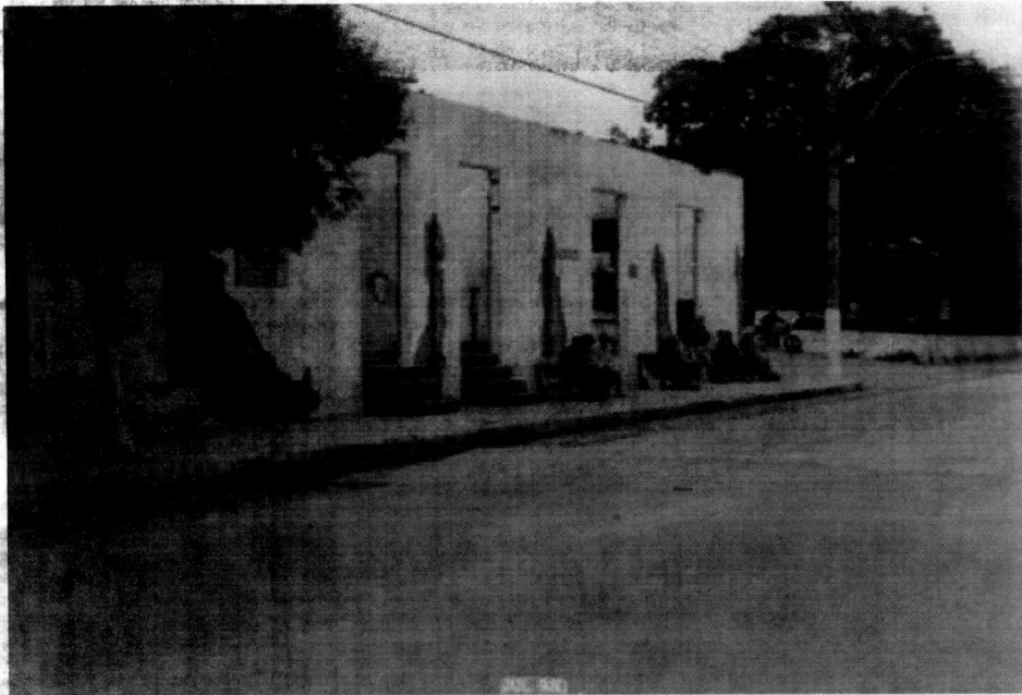
A estação de Conduru, reconstruída, em 15/11/2005. Foto Marcos A. Farias
