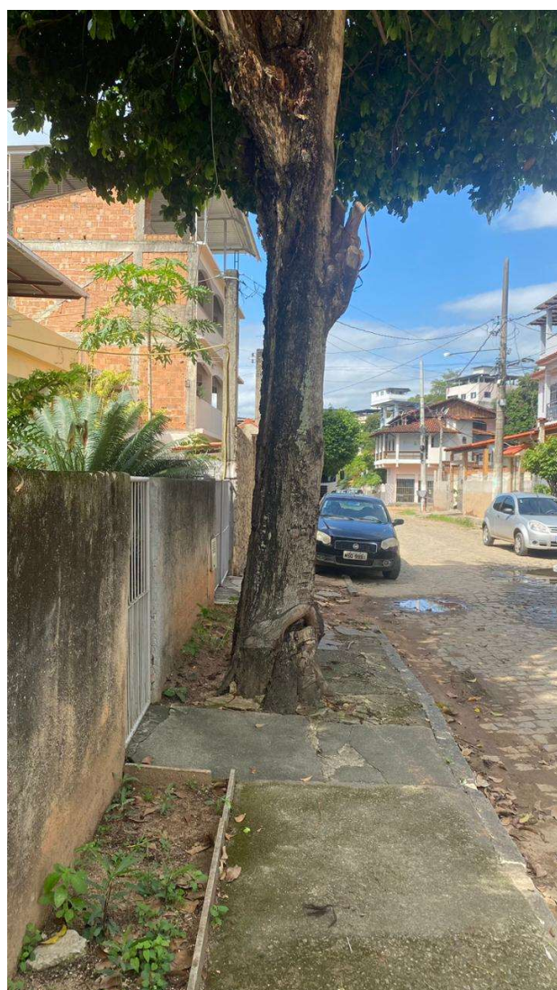
Figura 6. Visão geral da castanhola. Principais problemas observados: inserida em local incompatível com o seu porte; podridão de parte do lenho; risco de queda.
