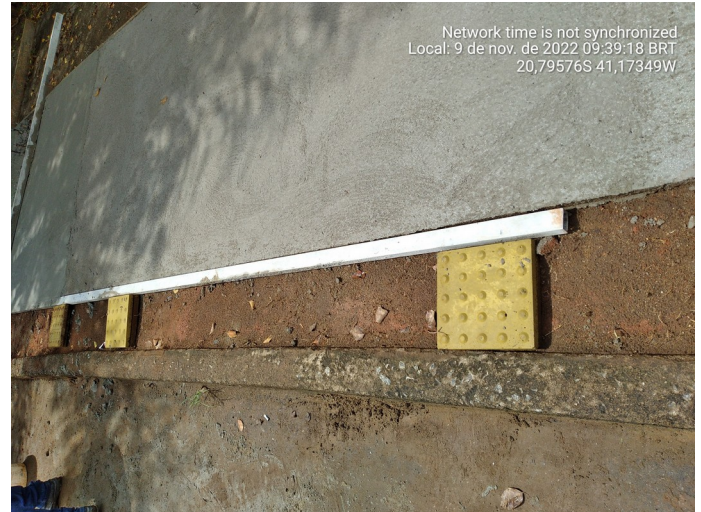
Figura 2 - Implantação de calçada sobre terreno limpo (retirada de mureta) e alinhamento com o meio-fio da avenida.
