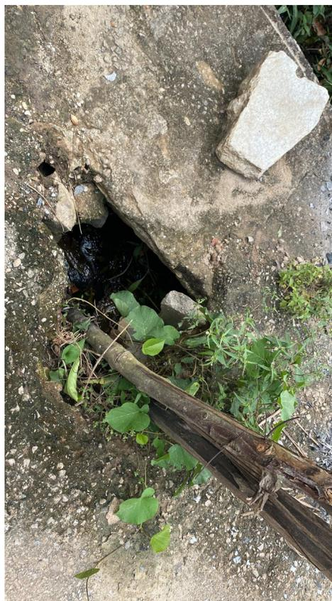
Figura 26: Trecho do córrego vistoriado (Ponto 14). Canal de drenagem assoreado.
