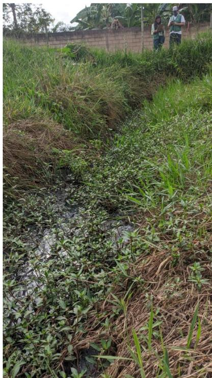
Figura 04: Trecho do córrego vistoriado (Ponto 03). Canal de drenagem com acúmulo de sedimento e estabelecimento de vegetação cobrindo o leito.
