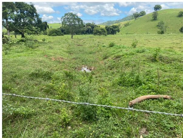
Figura 22: Trecho do córrego vistoriado (Ponto 12). Canal de drenagem assoreado.
