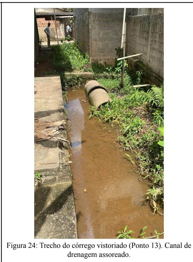
Corrente de água de coloração escurecida e com cheiro característico de esgoto, bueiro e obras de arte corrente obstruídas, leito assoreado. Área sujeita a enchentes e alagamentos.
