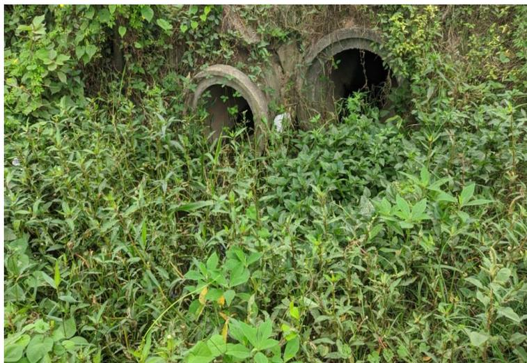
Figura 18: Vegetação cobrindo o curso hidrico e entupindo as manilhas. (Ponto 10).
