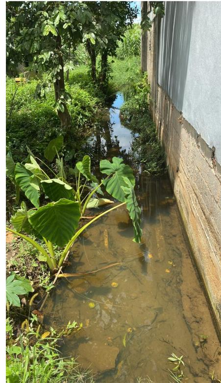
Figura 28: Trecho do córrego vistoriado (Ponto 15). Canal de drenagem assoreado.
