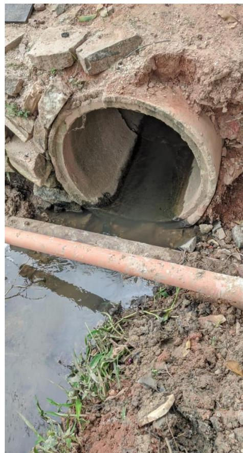
Figura 11: Canal de drenagem assoreado e escoamento de esgoto da manilha. (Ponto 06).
