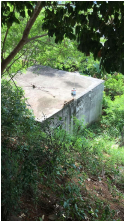
Figura 5. Castanhola inserida em talude.
