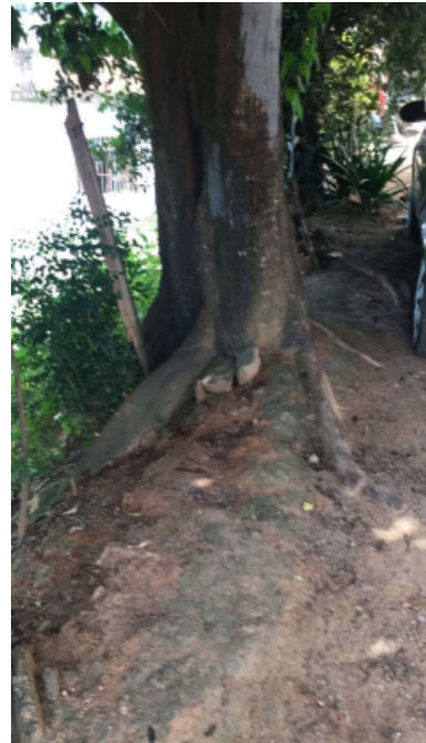
Figura 4. Sistema radicular exposto. Árvore em talude.
