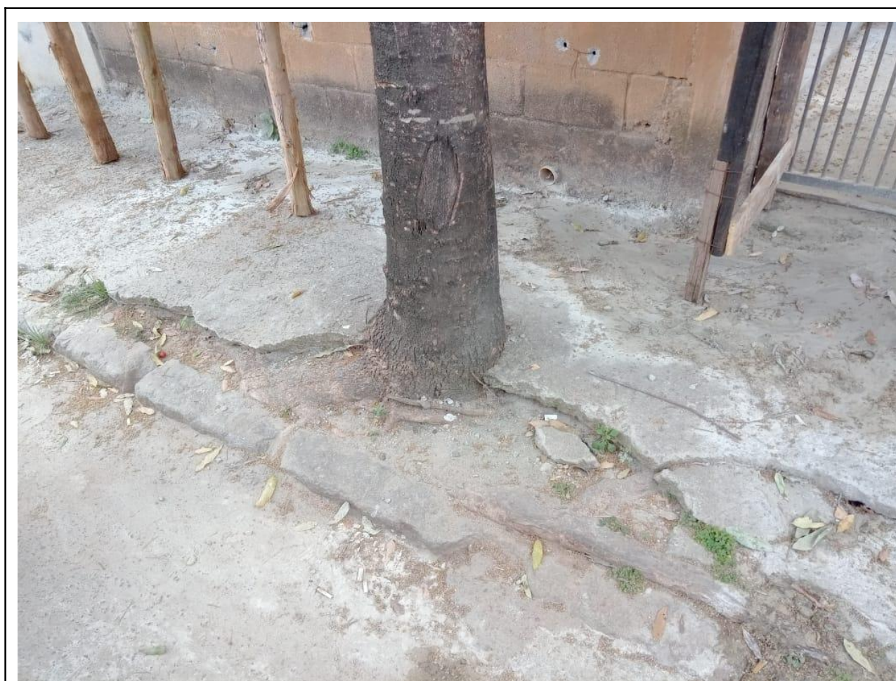
5.3. Sistema radicular rachando a calçada. Deixar uma área livre de pavimentação de 30 cm x 60 cm.
