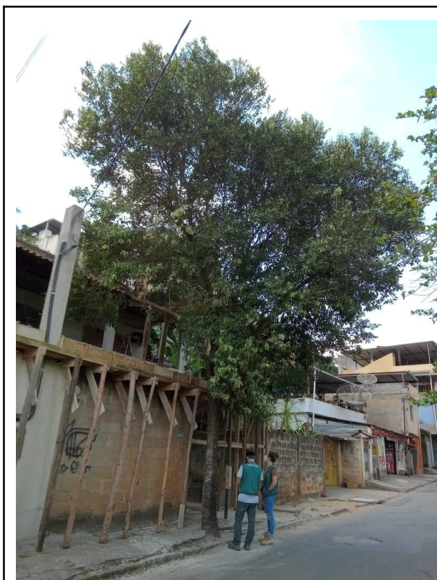
5.5. Árvore na calçada e residência em reforma/construção. Recomendação de poda para eliminação dos conflitos.
