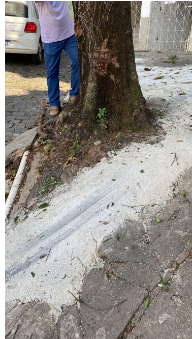
Foto 04. Necessidade de adequação da área livre permeável.
