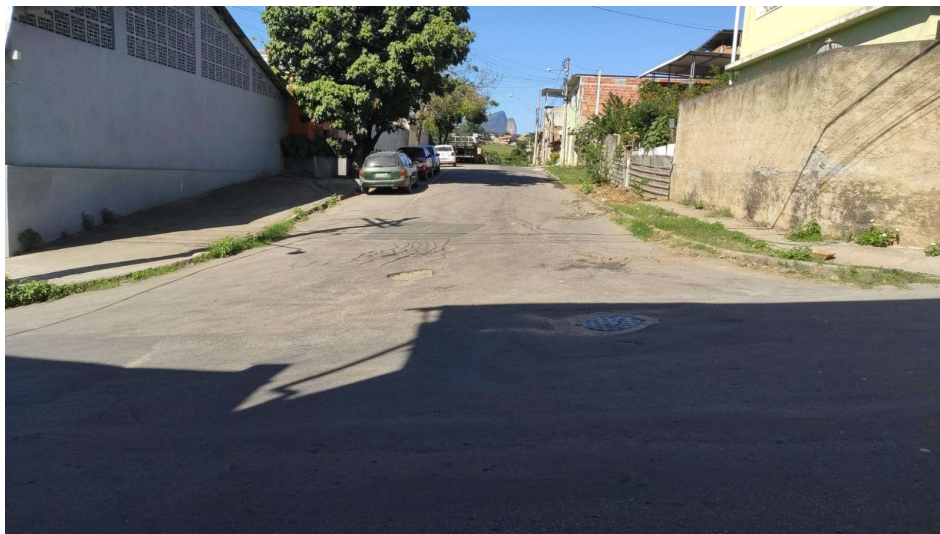
Foto 02 - Foto evidenciando trecho da Rua Aldeir de Almeida.
