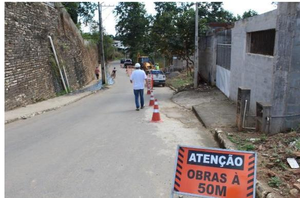
Foi realizada uma vistoria técnica no dia 11/08/2023 na obra de extensão de rede de esgoto, e no momento da vistoria foi observado que a equipe havia executado um PV e o recobrimento da vala.
