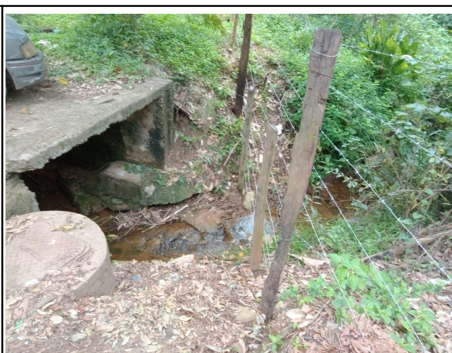
Figura 03. Início de galeria em área de transição entre meio urbano e meio rural. Água com coloração transparente e mais límpida. Esquina entre a Rua Arthur Prata e a Rua Manoel Belmiro dos Santos, Bairro Abelardo Ferreira Machado.
