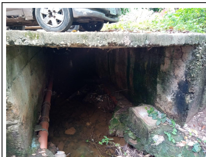
Figura 02. Início de galeria em área de transição entre meio urbano e meio rural. Água com coloração transparente e mais límpida. Esquina entre a Rua Arthur Prata e a Rua Manoel Belmiro dos Santos, Bairro Abelardo Ferreira Machado.
