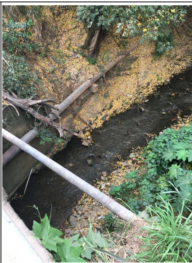
Figura 33. À jusante. Área com gramíneas, herbáceas e plantas aquáticas. Presença de resíduos sólidos orgânicos no local. Rua Ziul Pinheiro, Bairro Coronel Borges.
