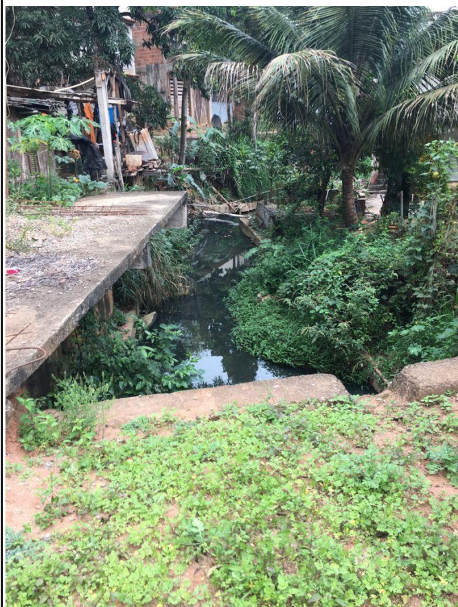
Figura 12. Obras de arte com acúmulo de resíduos vegetais, lixo e vegetação gramínea, herbácea e aquática. Água com coloração escura/acinzentada e com mau cheiro. Próximo da Rua João Barbosa, Bairro Nossa Senhora Aparecida.
