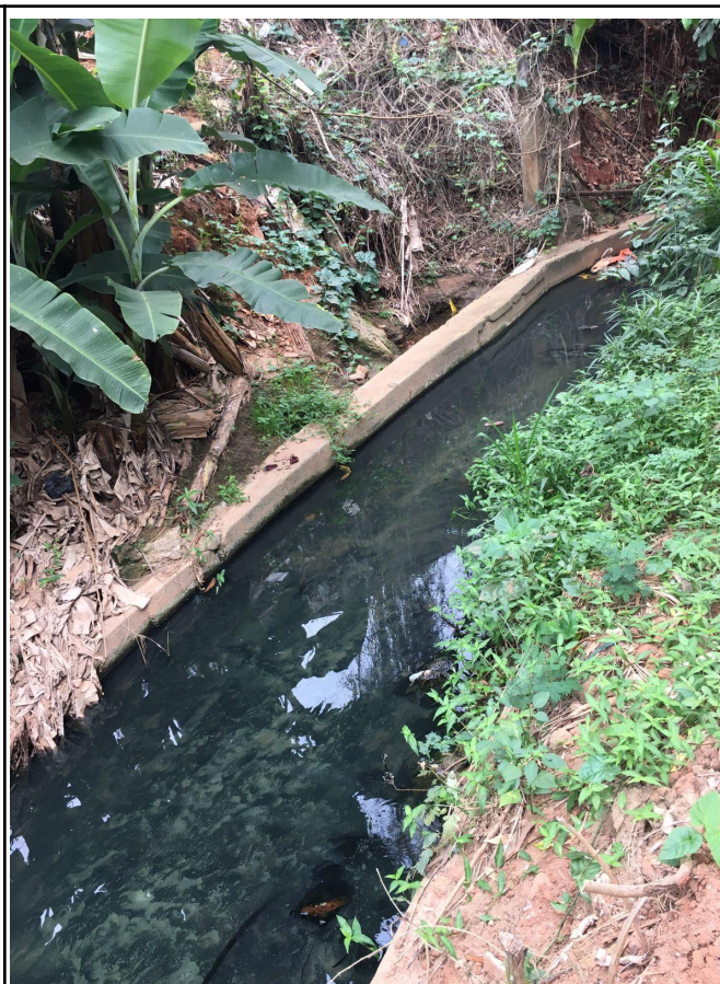
Figura 19. Água com coloração acinzentada e com mau cheiro. Vegetação gramínea, herbácea e aquática no leito e nas margens. Esquina entre a Rua João Barbosa e a Rua Alcino Barbosa de Moraes, Bairro Nossa Senhora Aparecida.
