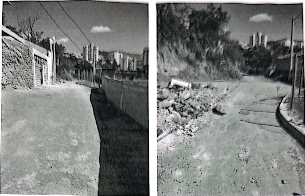
Fotos 03 e 04: início do trecho da Rua João XXIII sem pavimentação. Trecho inicial é estreito devido ao corte irregular de terreno com desmoronamento de talude.
