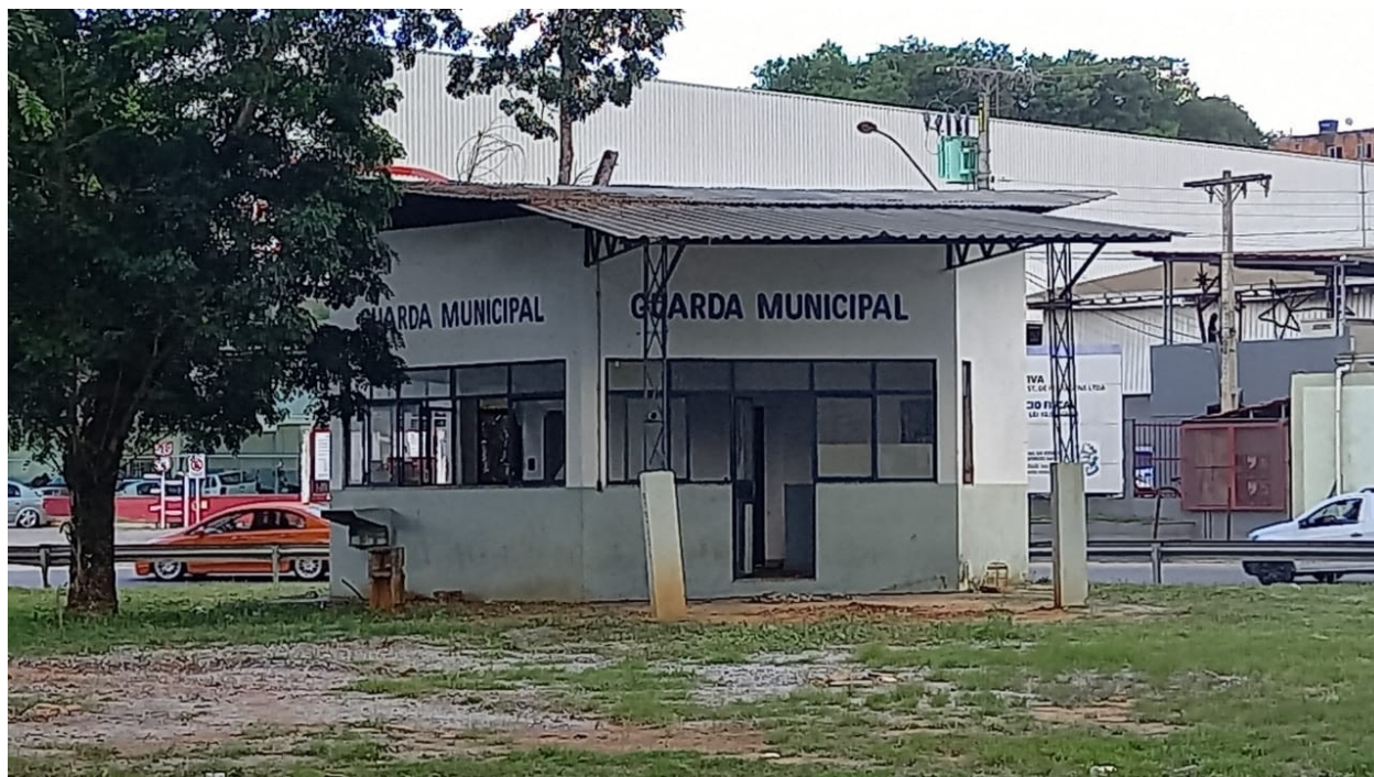
Figura 1: Posto da Guarda Municipal no bairro Aeroporto
