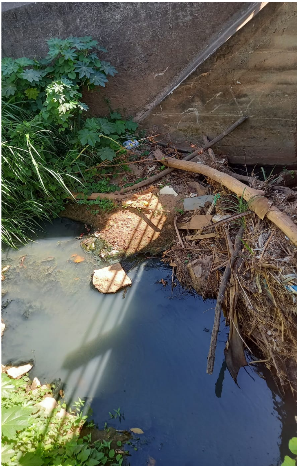
Figura 1: GALHOS OBSTRUINDO A BOCA DA PONTE
